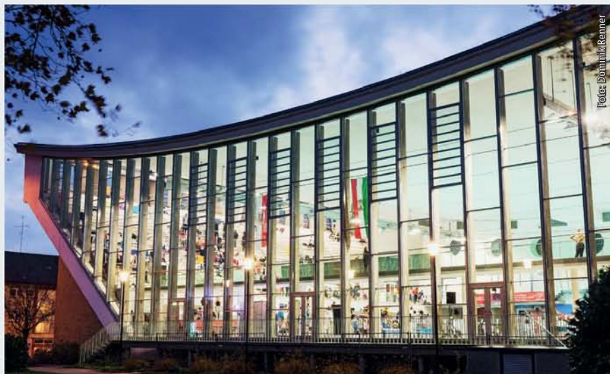
Abb. 2: Bei Gebäuden mit größeren Menschenansammlungen regelt das Bauordnungsrecht die Aufschlagrichtung der Türen im Zuge von Rettungswegen.
