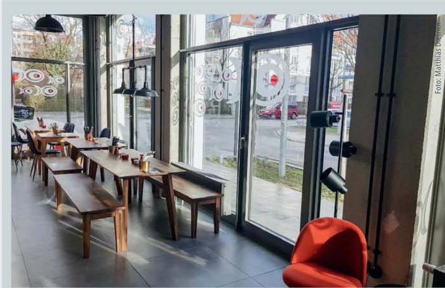
Der erste Eindruck täuscht. Um den Vorschriften des Arbeitsschutzes gerecht zu werden, musste diese Notausgangstür in den Bauvorlagen als „ebenerdiges Rettungswegfenster ohne Brüstung“ bezeichnet werden.
