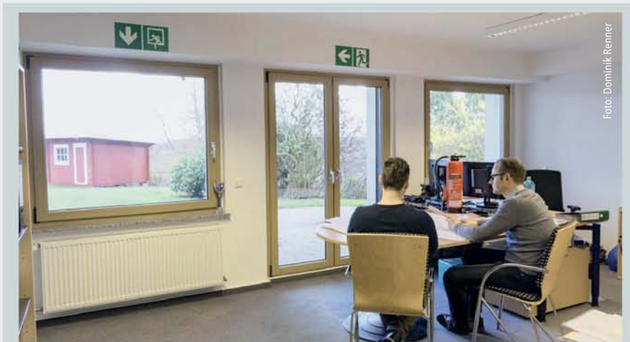
Zur Abwehr einer konkreten Lebensgefahr für die zwei Nutzer dieses Büroraumes führt der zweite Rettungsweg nicht durch die Ausgangstür ins Freie, sondern über ein Rettungswegfenster.
