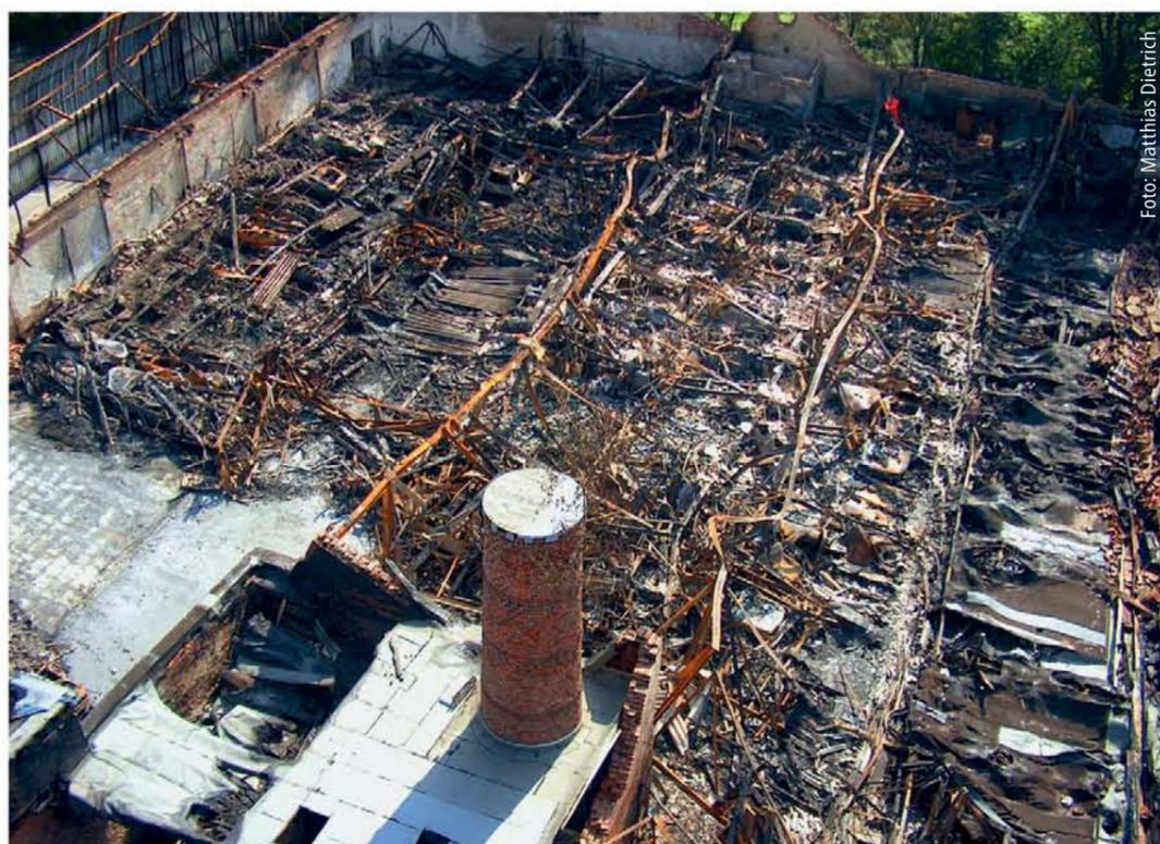
Abb. 2: Der Totalverlust eines Brandabschnitts stellt das durch den Gesetzgeber bemessene, gesellschaftlich akzeptierte Restrisiko dar.
