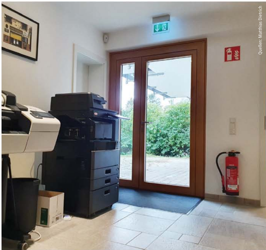
Abb. 3: Rettungswege, die im Alltag regelmäßig im Sinne der üblichen Erschließung genutzt werden, stellen im Regelfall kein besonderes Risiko hinsichtlich der Türaufschlagrichtung dar.
