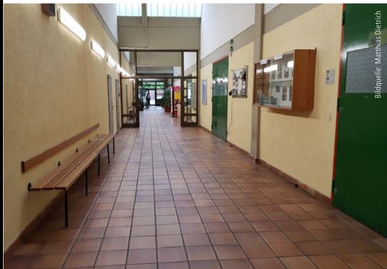
Abb. 3: Einbauten innerhalb notwendiger Flure sind in § 36 Absatz 6 MBO nicht geregelt. Sie sind somit zulässig, soweit sie die Benutzbarkeit des Rettungsweges nicht unzulässig einschränken.
