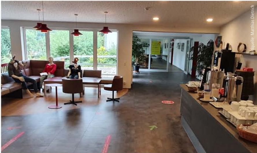
Abb. 5: Ein notwendiger Flur, der als Rettungsweg dient, sollte nicht gleichzeitig Aufenthaltsraum sein.
